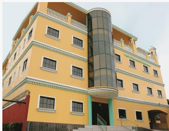
Hospital Monte Espana - 13 ед. - Никарагуа
